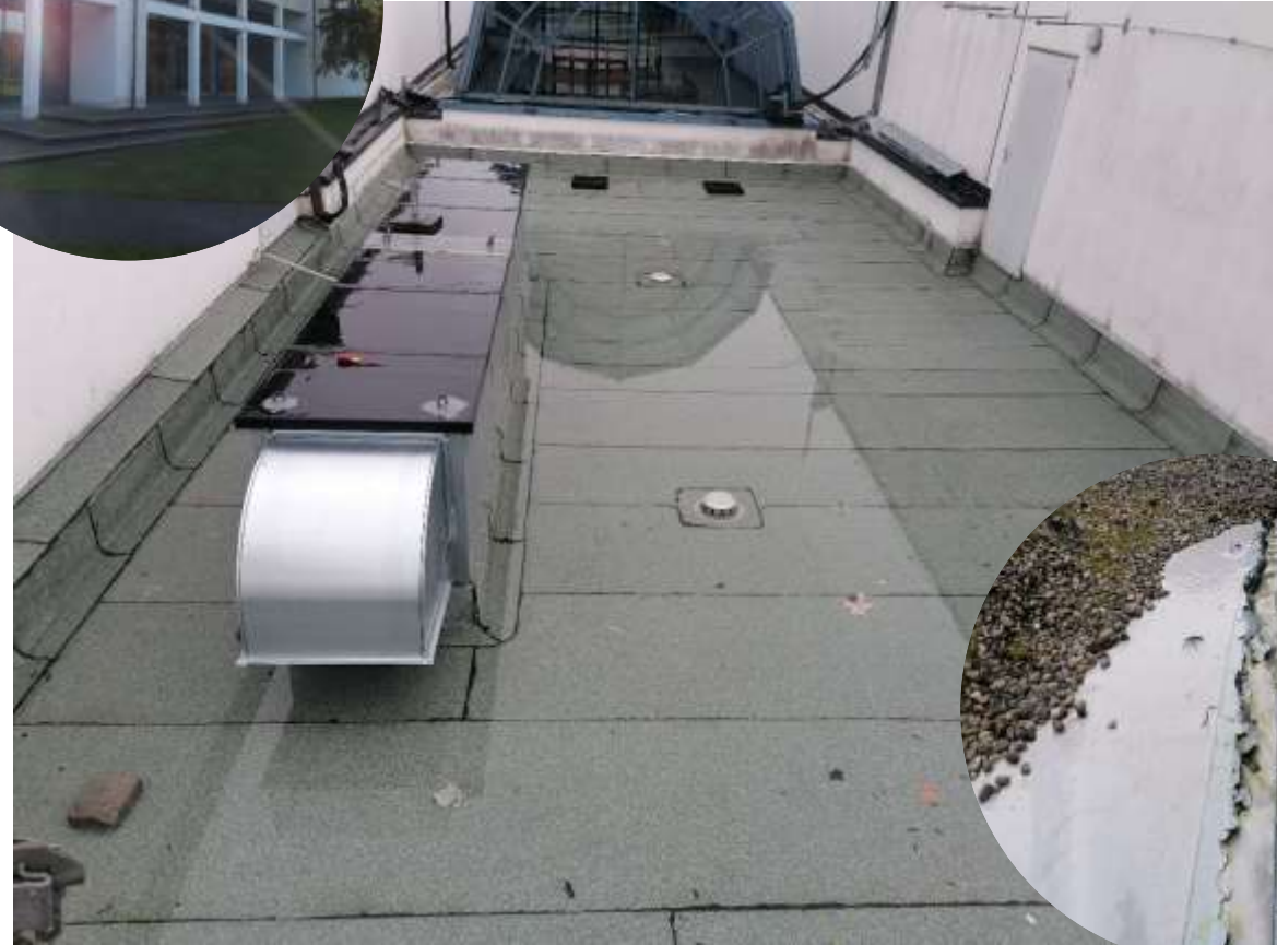
Neues Flachdach vor Bekiesung
