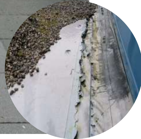
Foliendach vor Sanierung
