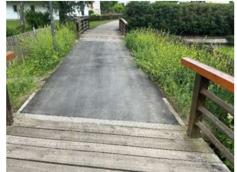
Fotos nach Fertigstellung
